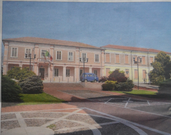
Il municipio di Pincara con le scuole adiacenti: i lavori sono stati eseguiti a tempo di record, rispetto ad altri comuni colpiti
